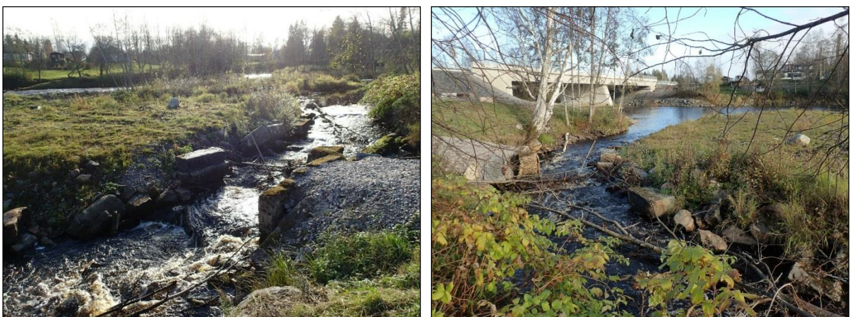
Vasen: Raasakankosken kivi- ja betonirakenteita. Eteläkaakkoon. Oikea: Raasakankosken betoni- ja kivirakenteita. Koilliseen.
